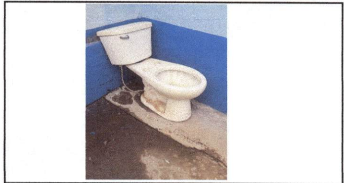
Foto 6: Se sustituye el inodoro en mal estado.
